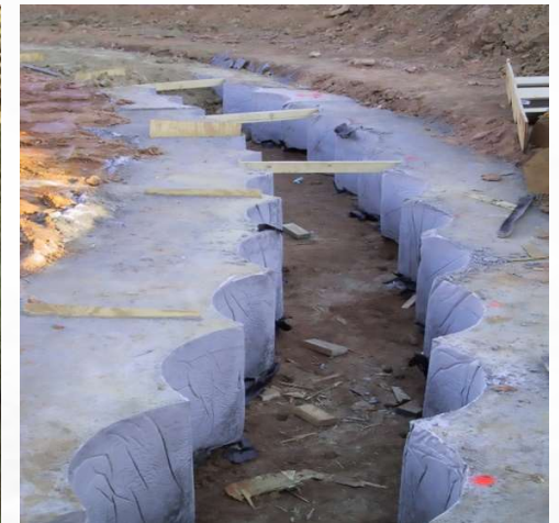
Secant Pile의 Guide wall
