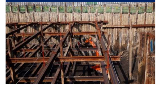
옥동~농소1 도로 개설공사
