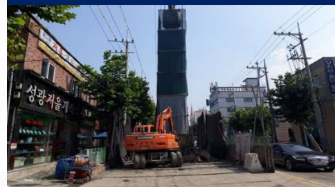
부산지하철 사상~하단 1공구
