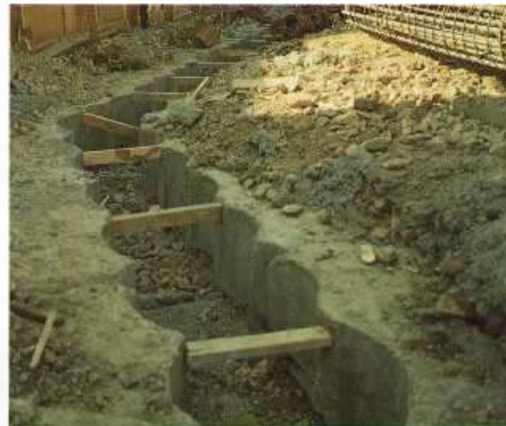
Secant Pile의 Guide wall
